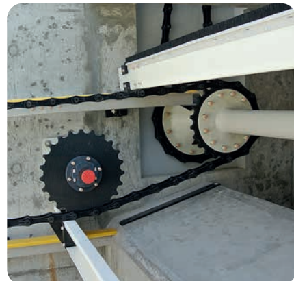
Flotaträumer komplett in Kunststoff
