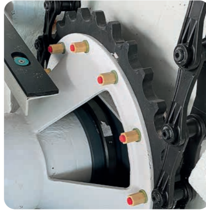
Flotaträumer komplett in Kunststoff
