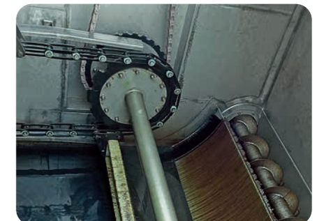
Schlammaustrag mittels Schnecke
