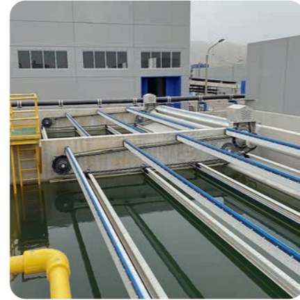
Meerwasser-Entsalzungsanlage mit DAF-Räumer komplett aus Kunststoff
